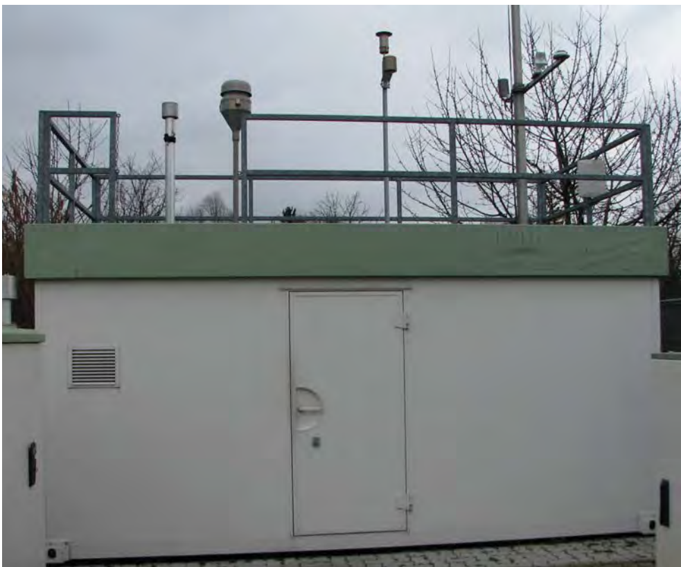
Abb. 4.2.1: Messstation auf dem Versuchsgelände der LUBW
