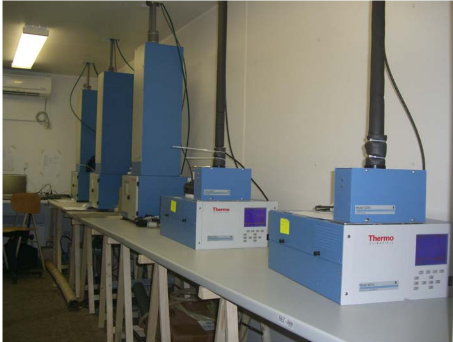
Abbildung 12: Messgerät Modell 5030i SHARP (1. & 2. System von rechts) in Messstation
