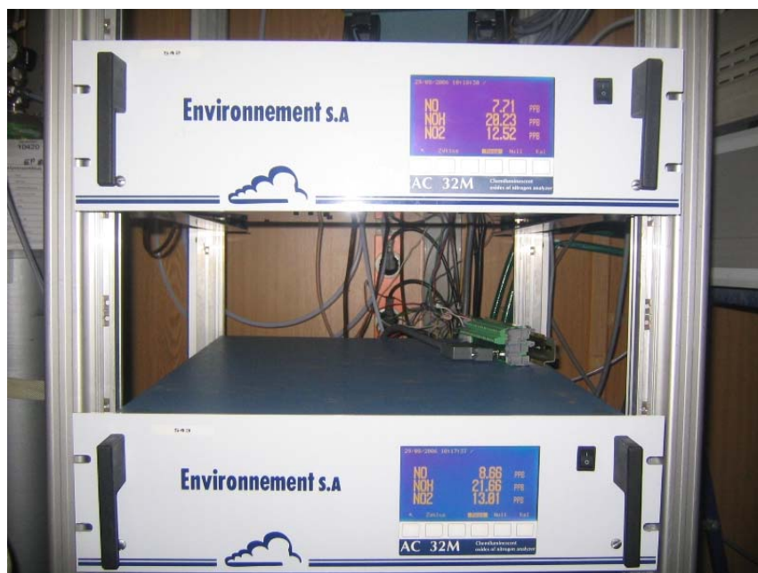
Abbildung 5: Frontaufnahme der im Messcontainer installierten Messeinrichtungen
